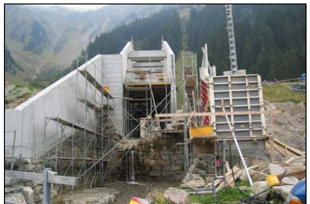
Abb. 4: Bau Auslaufbauwerk (Bild: Bauamt Klosters-Serneus)
