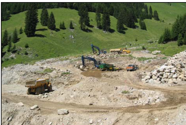
Abb. 3: Baubeginn Standort Fezi (Bild: Bauamt Klosters-Serneus)
