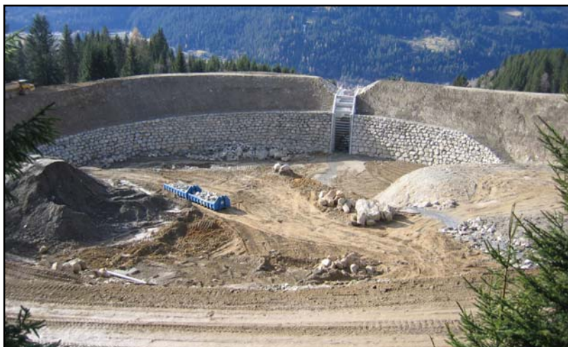
Abb. 5: Damm Tal in der Bauphase (Bild: tur gmbh)
