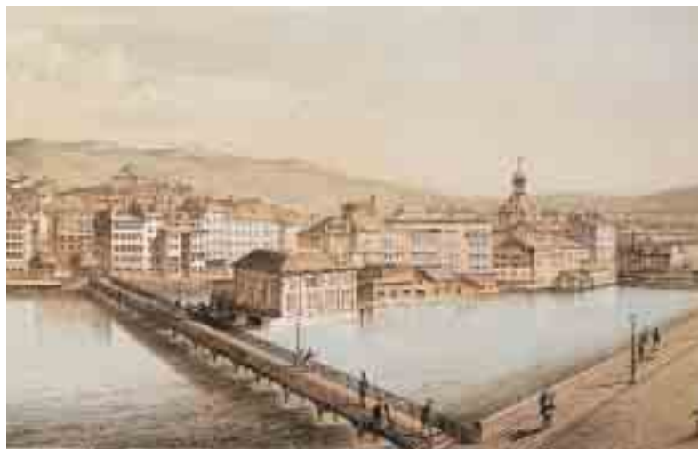
Fig. 192 Le pont de la Machine, avec la nouvelle station de pompage à la pointe de l'Île, sur le bras droit du Rhône, construite entre 1838 et 1843. Sens de l'écoulement: de gauche à droite. Lithographie de F. Tollin.
