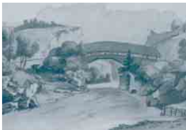
Fig. 67 Pont en bois à contre-fiches, dans le secteur inférieur de la coupure de la Kander. Il remplace le pont en pierres contemporain du chantier qui s'est effondré en 1746 suite à des phénomènes d'affouillement.
