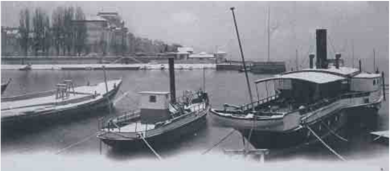
Fig. 116 Le chantier de la correction supérieure utilisa 5 bateaux de transport et 5 remorqueurs, acquis en 1876 puis revendus. On voit ici un de ces remorqueurs dans le port de Neuchâtel peu avant 1900, flanqué d'un bateau de transport et du bateau à vapeur «Jura».
