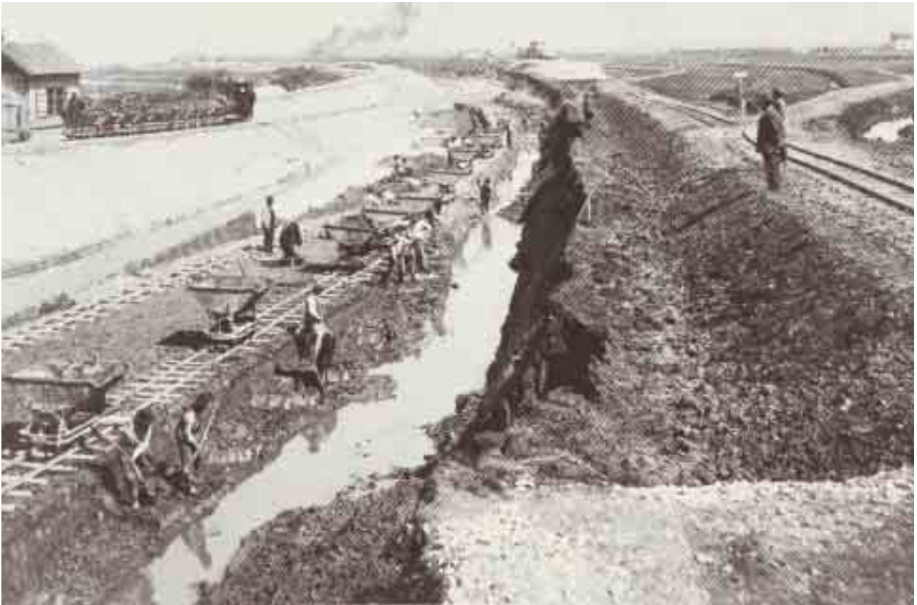
Fig. 47 Un certain degré de mécanisation n'exclut pas de gros travaux à la force des bras. Creusement de la coupure de Fussach, de 1895 à 1900.
