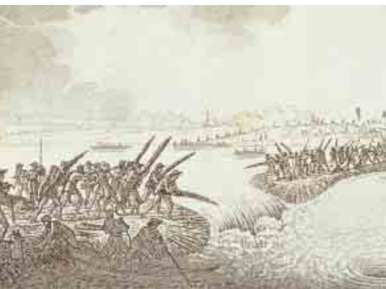
Fig. 33 Figure extraite du livre «Praktische Anweisung zur Bauart der Faschinenwerke und der dazu gehörigen Anlagen an Flüssen und Strömen» (Instructions sur la manière de construire des ouvrages en fascines et les installations associées dans des rivières et des fleuves) de J. A. Eytelwein, 1818. Obturation d'un bras de rivière au moyen de fascines.
