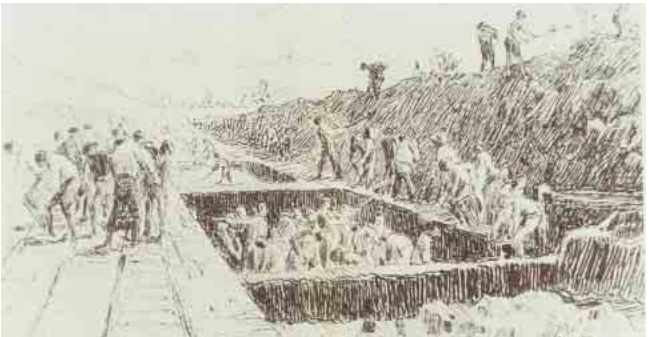
Fig. 113 Travaux de construction du canal-guide, sur le tronçon plat du canal de Hagneck, de 1875 à 1878. Interprétation d'une esquisse non datée ni décrite de A. Anker.
