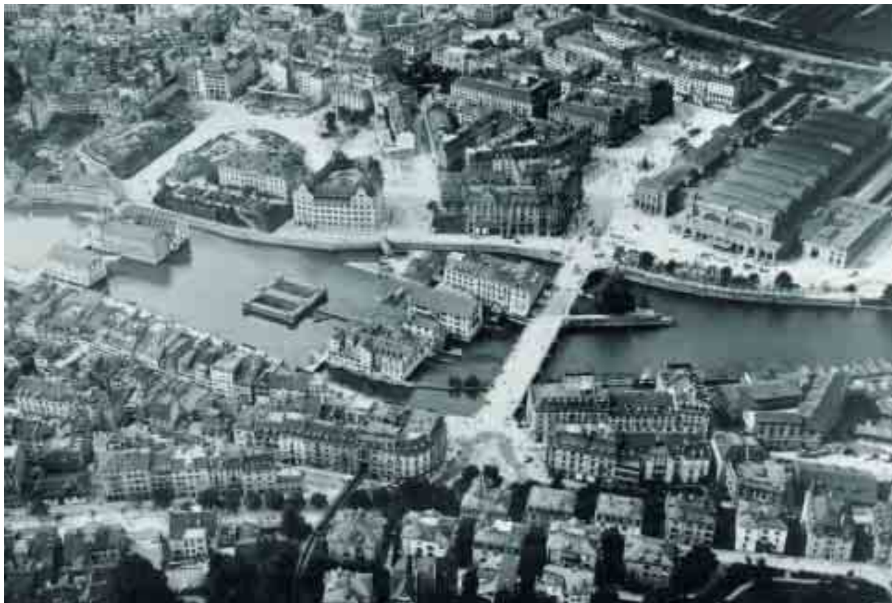
Fig. 186 La Limmat dans le secteur des deux Mühlestege et du Papierwerd (sens de l'écoulement: de gauche à droite). Le quai de la Limmat fut construit dans la rivière en 1859 pour soutenir une nouvelle route. Vue aérienne de E. Spelterini, 1904.
