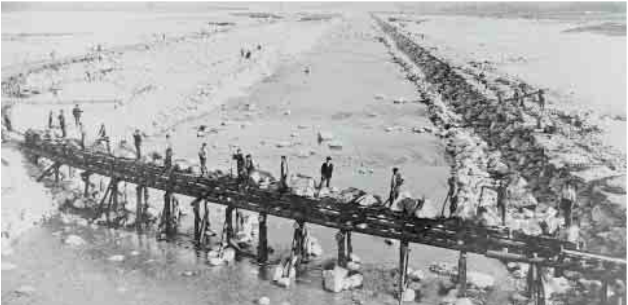
Fig. 146 Train transportant des blocs sur la Maggia en 1893. Photo de A. Monotti, vue dans le sens de l'écoulement.
