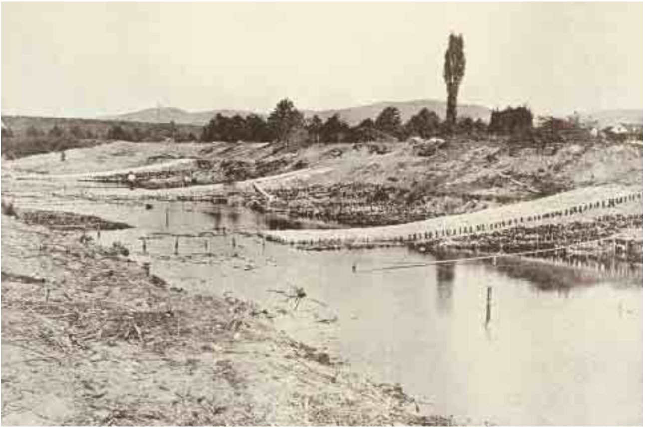
Fig. 168 Début de la construction en ceintures selon Schindler, dans le profil en cuvette du tronçon-test de la Wiese, 1897.
