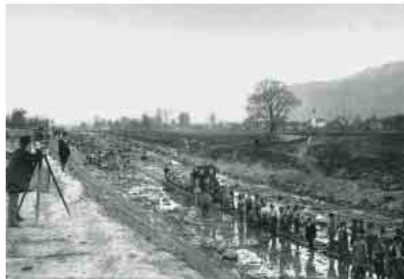
Fig. 93 Construction du canal d'assainissement de Werdenberg à Salez vers 1882. L'excavation et la stabilisation des berges se font à la main. Les transports utilisent une voie de chantier d'écartement 50 cm.
