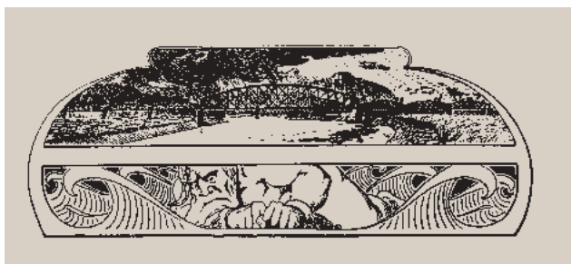
Fig. 9 Le Rhin est maîtrisé! En haut: le Rhin corrigé dans la coupure de Fussach, avec des ponts en acier construits entre 1899 et 1900. En bas: le Rhin enchaîné. Vignette de H. Scherrer.
