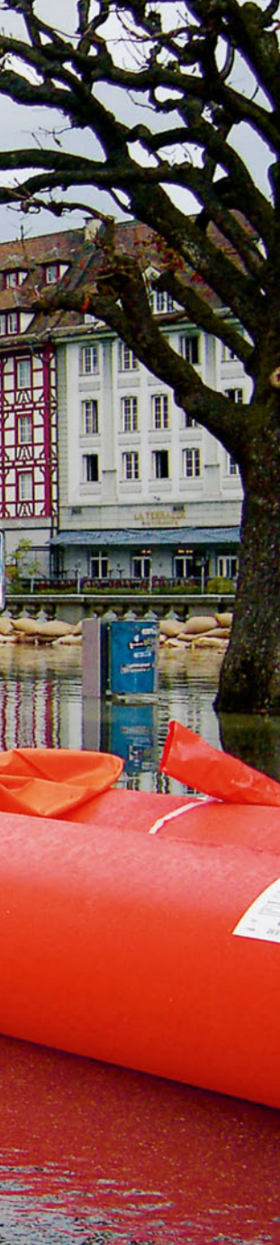
Protections mobiles contre les inondations (boudins Beaver) le long de la Reuss à Lucerne
